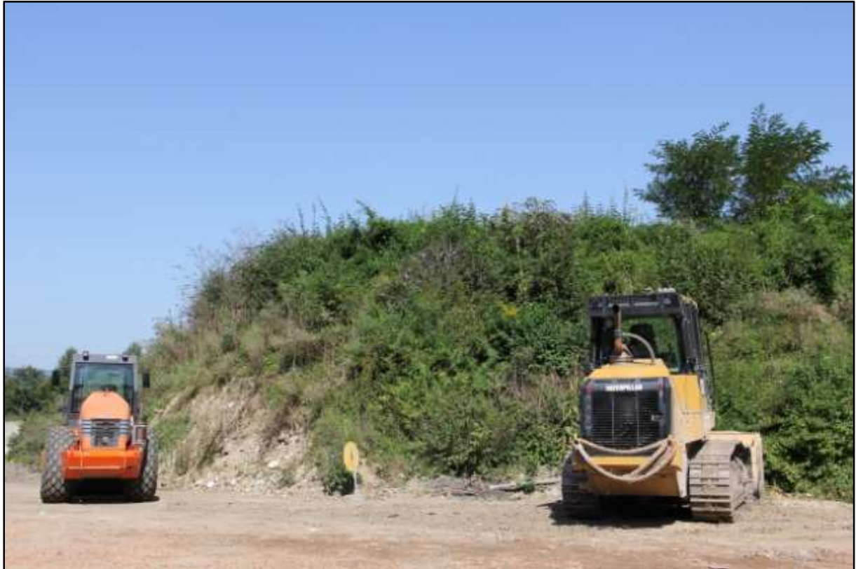
Abb. 41: Baumaschinen in unmittelbarer Nähe des Zauneidechsen-Habitats am Standort S3 (Bild: Schmid)
